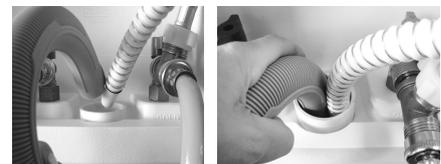
4. Un'altra opzione è mettere nello scarico i tubi flessibili insieme con il tubo di scarico di CatGenie più avanti dell'uscita del tubo di scarico della lavatrice. 5. Inserisca entrambi i tubi flessibili fino a fissarli saldamente dentro il tubo di scarico.
